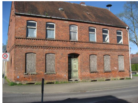
Abb.3: Bausicherung schützt „Substanz auf Abruf“
